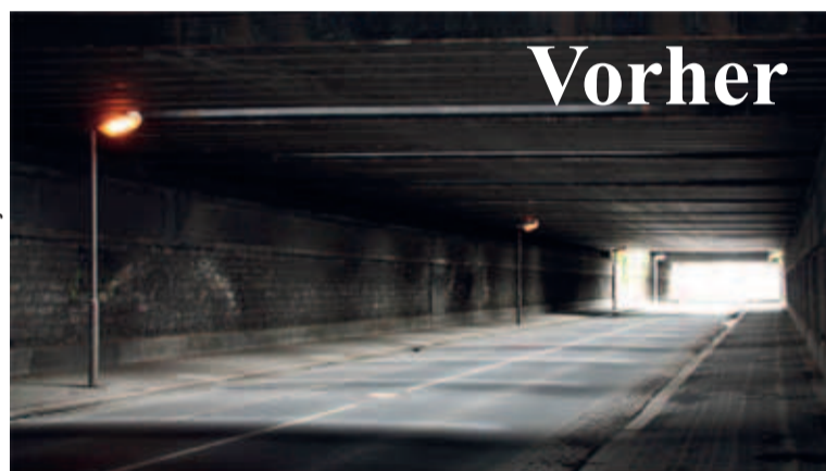
Der Goethetunnel, seit langer Zeit zum Fürchten für Fußgänger
