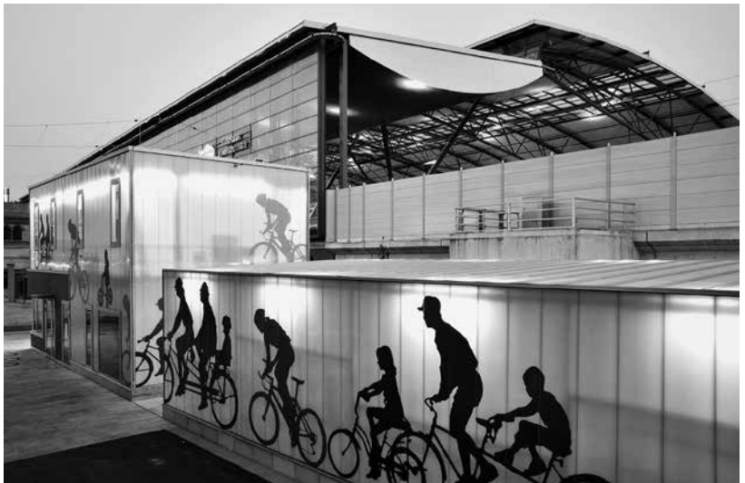
Fassade des *Radhaus
