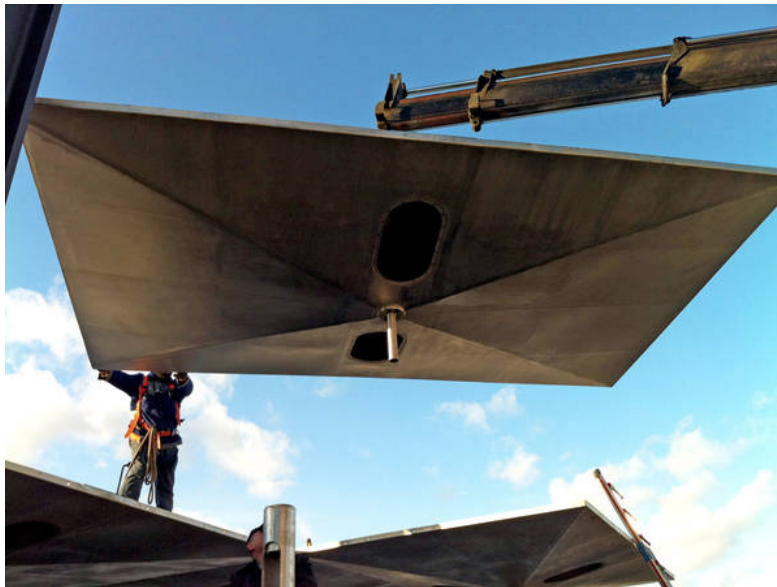
Die Montage der Dachelemente vor Ort, Foto: Syra_Schoyerer Architekten
