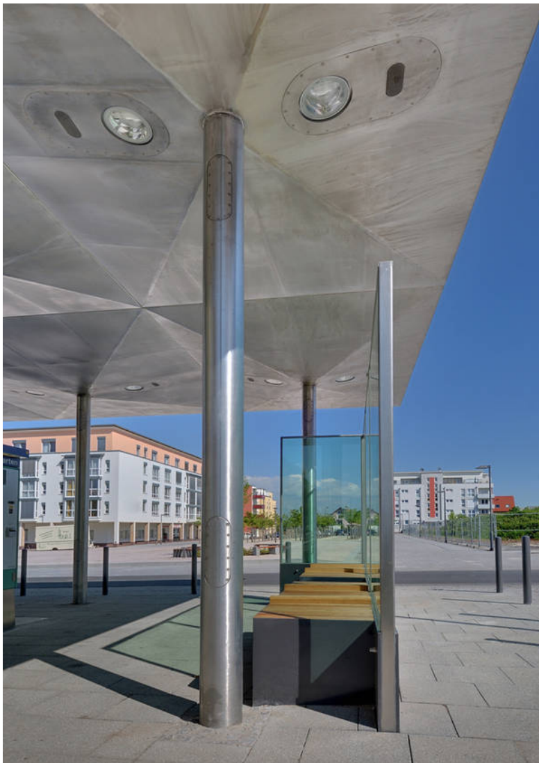
Die transparenten Windschutzwände (4-fach VSG Scheiben) bilden die Rücklehnen der Sitzbänke. Foto: Stefan Klomfass
