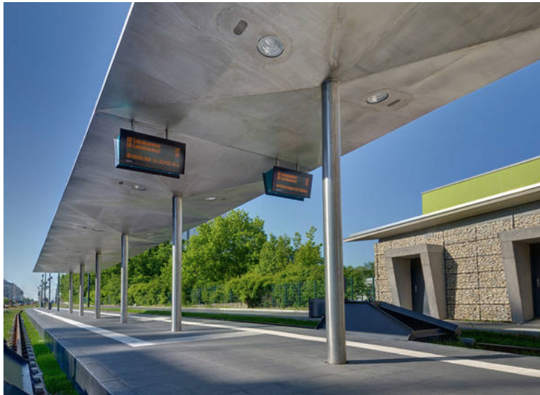
Die 11 Tonnen schwere Dachfläche wird von schlanken Edelstahlrundstützen getragen. Foto: Stefan Klomfass
