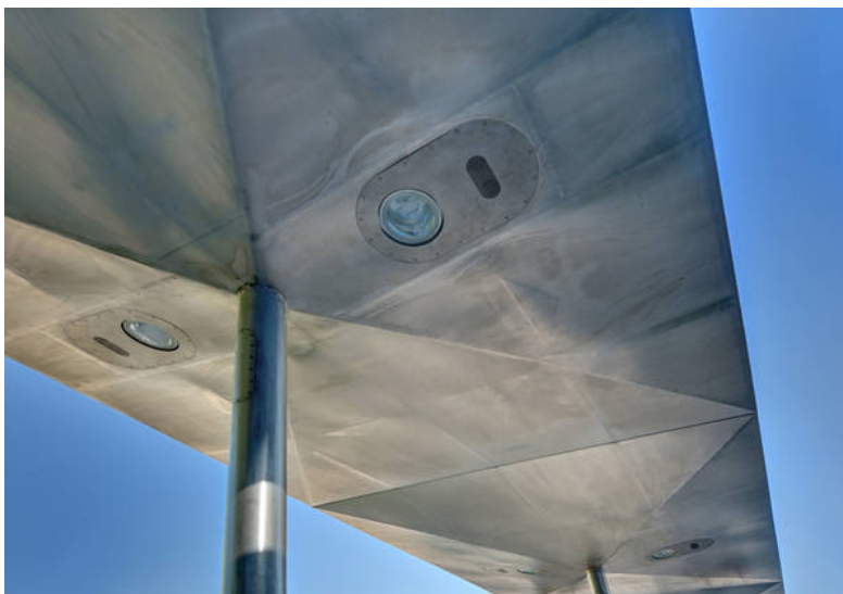
Die Edelstahl einzeldächer ruhen auf schlanken Edelstahlrundstützen, Foto: Stefan Klomfass
