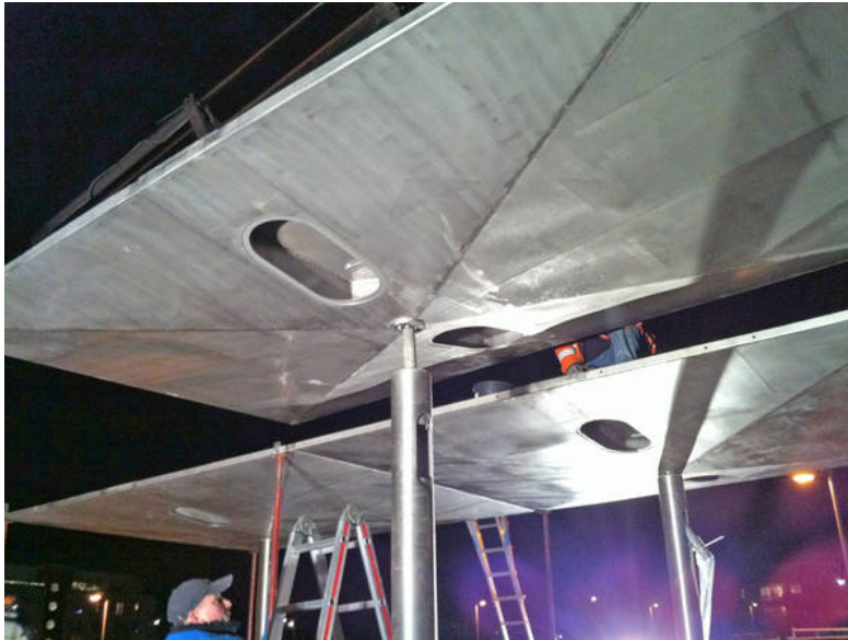
Baustellenfoto: Syra_Schoyerer Architekten
