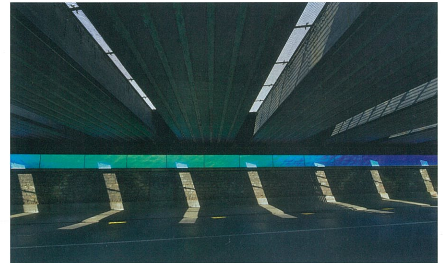
Die Patina der alten Tunnelwände wird nicht angegriffen
