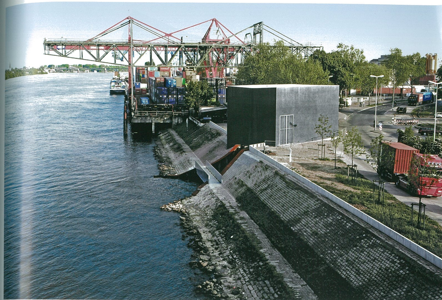
Blick auf den Mainzer Zoll- und Binnenhafen mit dem Hochwasserpumpwerk. View of Mainz's inland port with floodwater pumping station
