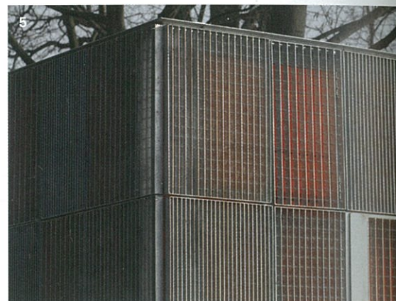
↑ → 5–7 / Gleichrichterwerk Rennbahnstrasse, Frankfurt a.M.
