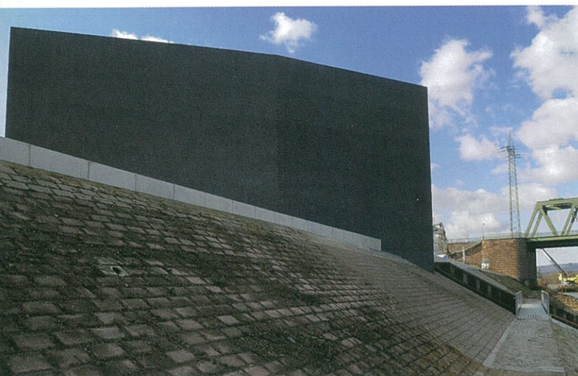
Außergewöhnlich: Das neue Hochwasserpumpwerk in Mainz bietet Ästhetik und Funktionalität in einem
