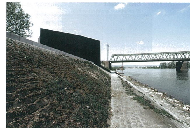
Pumpwerk und Kaiserbrücke © schoyerer architekten BDA
