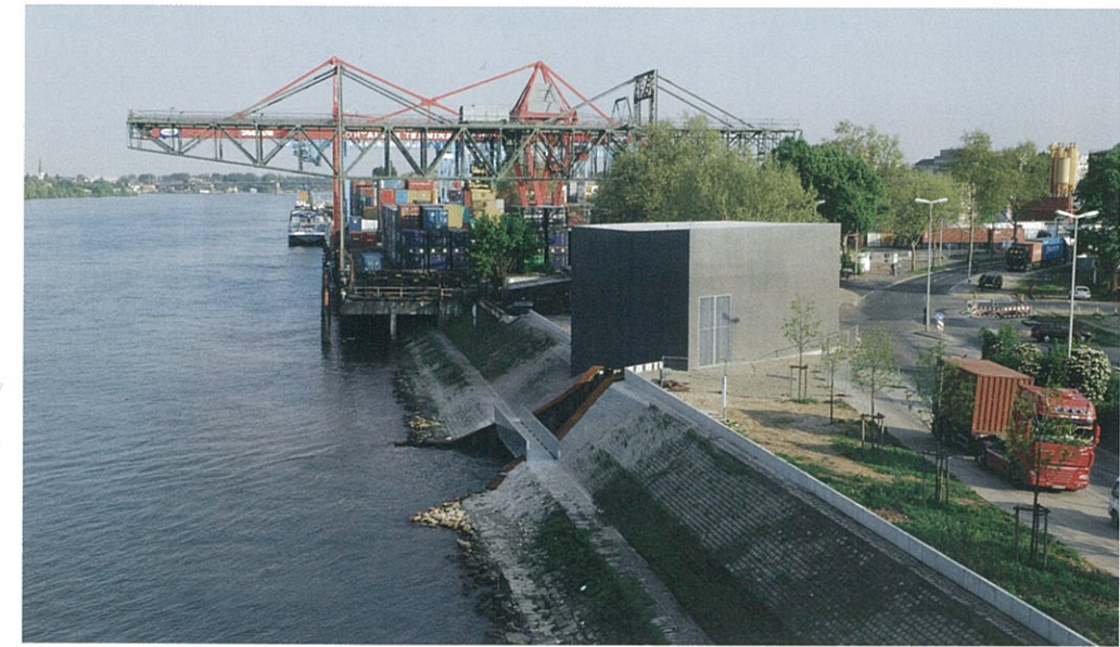
Zoll- und Binnenhafengelände... © schoyerer architekten BDA
