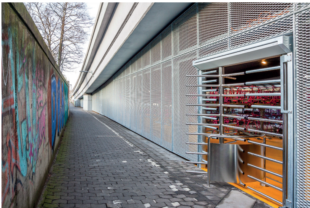
Drehkreuzzugang zum kostenpflichtigen Abstellbereich © SCHOYERER ARCHITEKTEN_SYRA/Marc Nehrbaß
