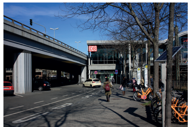
Blick entlang der Trasse vor dem Umbau © SCHOYERER ARCHITEKTEN_SYRA/Jonas Klingenschmitt
