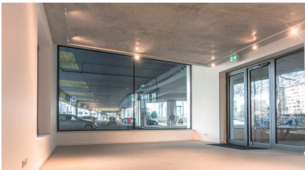
Servicestation in der Ausbauphase © SCHOYERER ARCHITEKTEN_SYRA/Marc Nehrbaß
